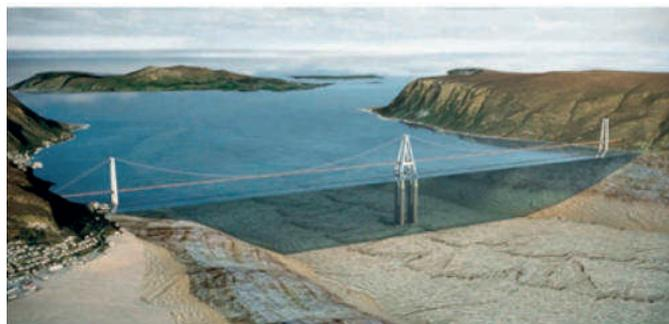
Figura 28 – Progetto del ponte stradale a due campate da 2000 m per l'attraversamento del Sulafjorden (Statens vegvesen).
