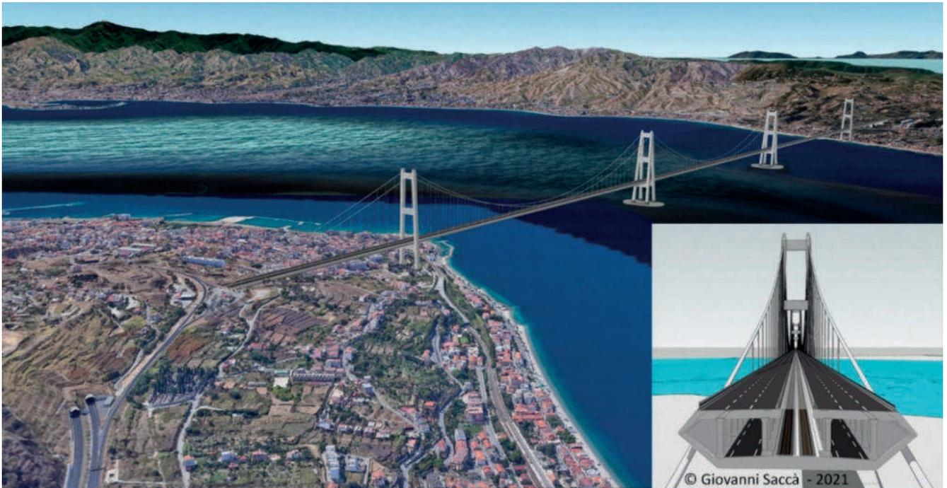
Figura 33 – Ipotesi di ponte sospeso multicampata con impalcato a due piani [74][75], che potrebbe essere anche ibrido H.R.S.B. per ridurre le flessioni dell'impalcato al passaggio dei treni [76].
