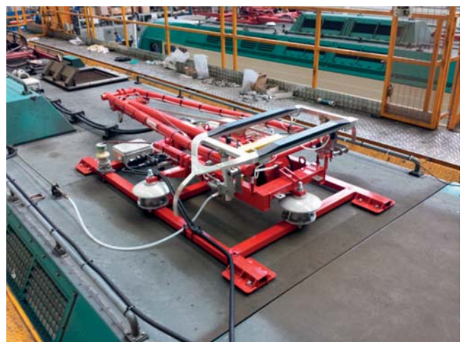
Fig. 4 - Installazione pantografo tipo JRC15 su locomotiva E464.430.
