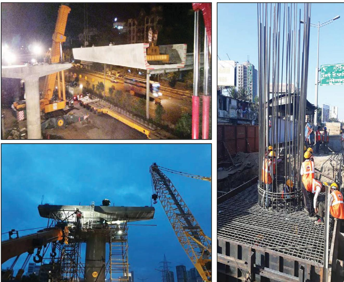
Fig. 9 - Alcuni immagini riprese durante audit ed ispezioni in fase di costruzione. In alto a sinistra: fase di elevazione di una trave ad "U"; a destra: montaggio ferri di armatura di una pila; in basso a sinistra: montaggio pulvino).
