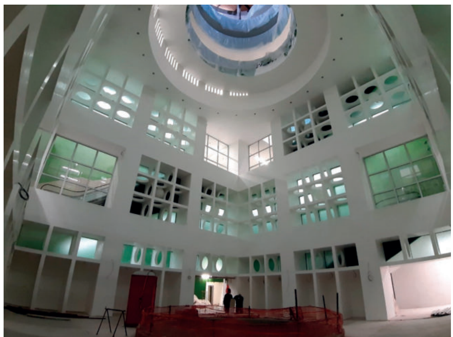
Figura 10 – Esempio di foto dal cantiere della lanterna interna.
