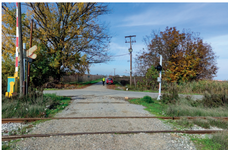
Figura 2 – RLC attivo – Attraversamento tra una linea ferroviaria principale a binario unico con una strada rurale/locale con traffico stradale giornaliero minimo sulla rete ferroviaria greca [8].
