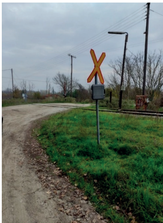
Figura 1 – RLC passivo – Attraversamento tra una linea ferroviaria principale a binario unico e una strada rurale con traffico stradale giornaliero minimo sulla rete ferroviaria greca [8].
