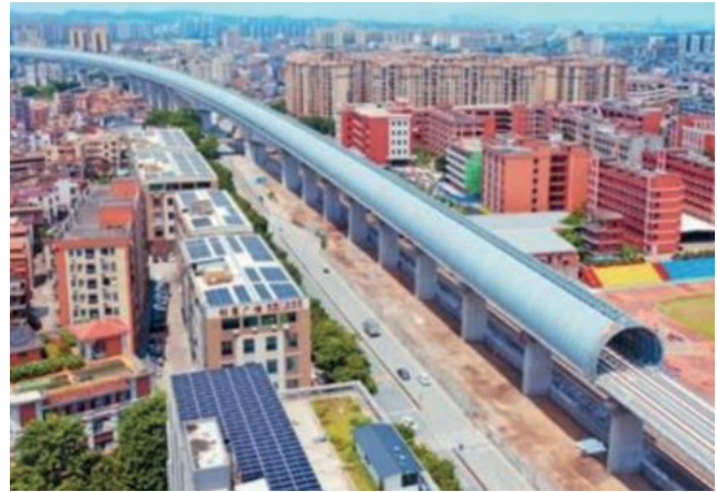
(Fonte - Source: Ferrovie dello Stato Cinesi) Figura 3 – Ricostruzione in simulazione della galleria insonorizzante per transito di treni Av in una città cinese. Figure 3 – Simulation reconstruction of the soundproof tunnel for high speed trains in a Chinese city.
