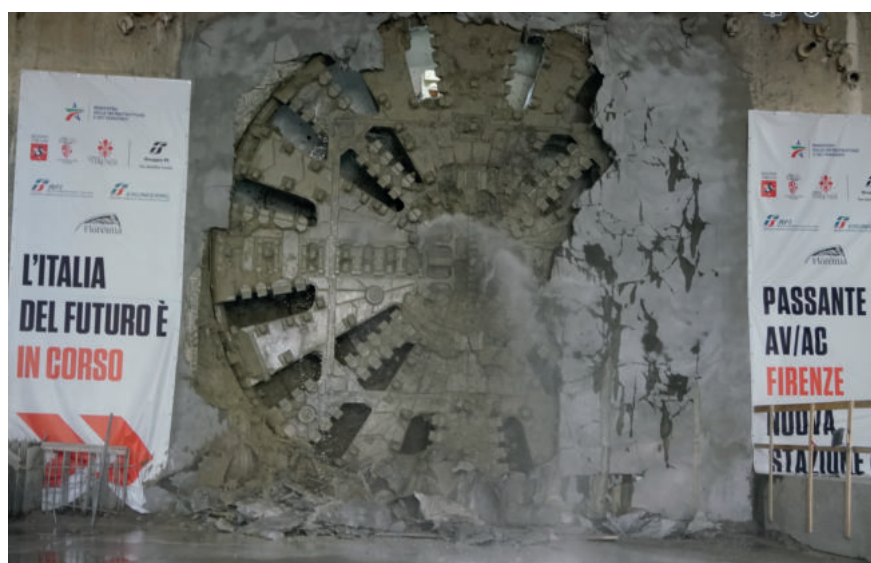
Figura 2 – La TBM abbatte l'ultimo diaframma completando lo scavo del passante di Firenze.
