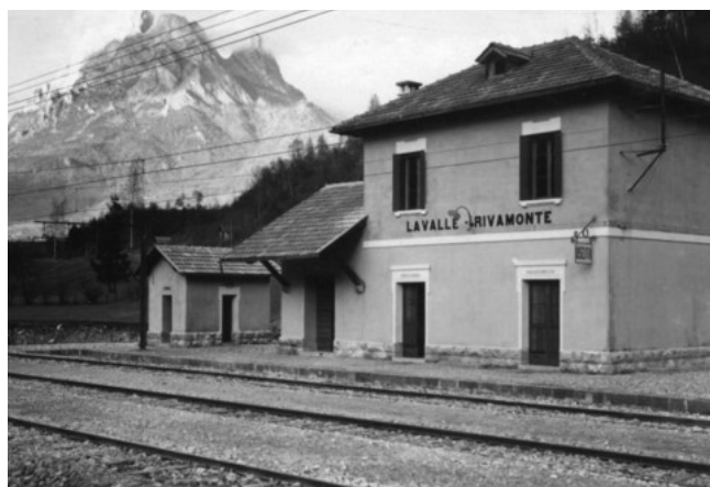
Figura 25 – La stazione di La Valle - Rivamonte. Figure 25 – La Valle - Rivamonte station.
