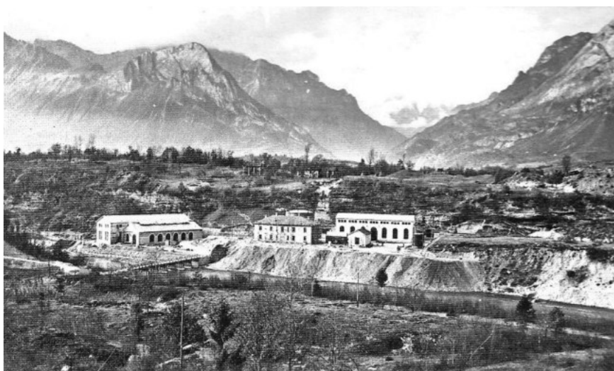
Figura 27 – Mas di Sedico - Le centrali di alimentazione della linea ferroviaria e annesso stabilimento per la produzione di ammoniaca. Figure 27 – Mas of Sedico - The power station of the railway line and attached ammonia plant.
