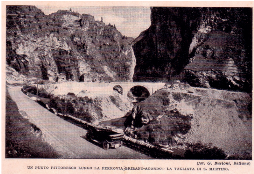
Figura 3 – Il tracciato presso la tagliata di San Martino. Figure 3 – The track at the Tagliata of San Martino.
