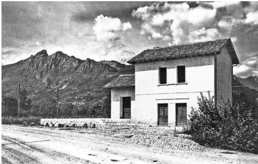
Figura 20 – La stazione di Le Roe. Figure 20 – Le Roe station.
