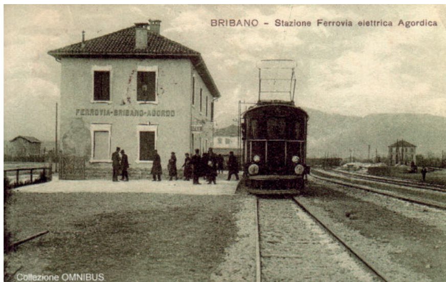
Figura 18 – Stazione di Bribano. Figure 18 – Bribano station.
