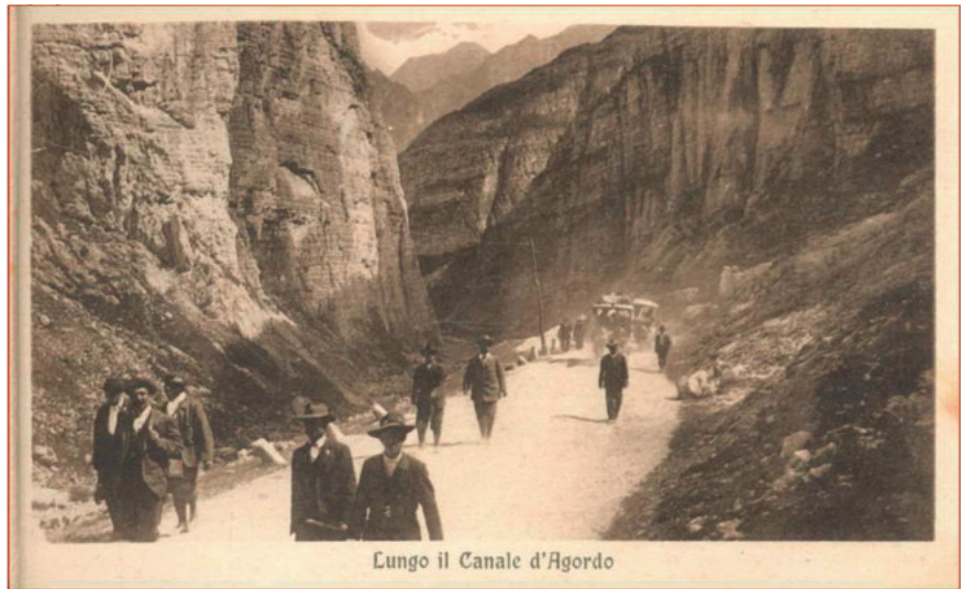
Figura 6 – Lungo il Canale d'Agordo (strada). Figure 6 – Along the Agordo Canal (road).
