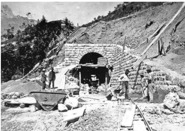
Figura 11 – I lavori di costruzione della galleria di Ponte Alto all'imbocco sud.
