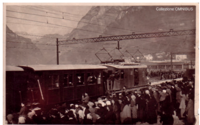
Figura 33 – Stazione di Agordo il giorno dell'inaugurazione. Figure 33 – Agordo Station on Inauguration Day.
