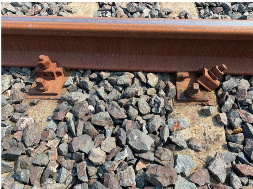
Figura 6 - Esempio di attacco integro e attacco ceduto.
