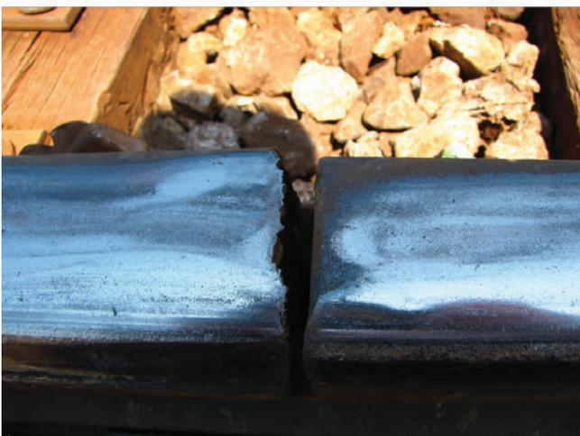
Figura 4 - Giunto di collegamento danneggiato.
