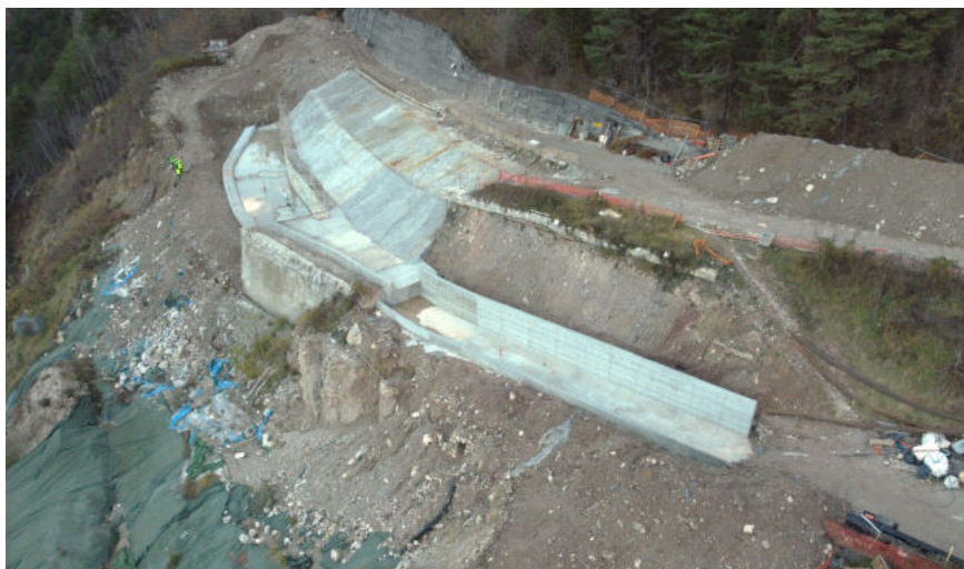
Figura 7 – La struttura in calcestruzzo armato vista dall'alto in rapporto al tracciato ferroviario dismesso superiore ed alla frana sottostante.
