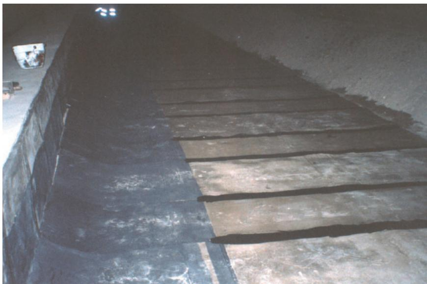
Figura 14 – Vista della vasca di contenimento della sede ferroviaria, dalla quale è stata rimossa la massicciata ed installato un materassino resiliente [20].
