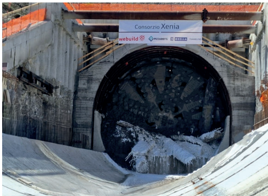
Figura 3 - Completato lo scavo da parte della TBM "Mireille", nell'ambito del Lotto 1A Battipaglia – Romagnano di circa 35 km con un investimento complessivo circa 2,9 miliardi di euro, in parte finanziato con fondi PNRR.
