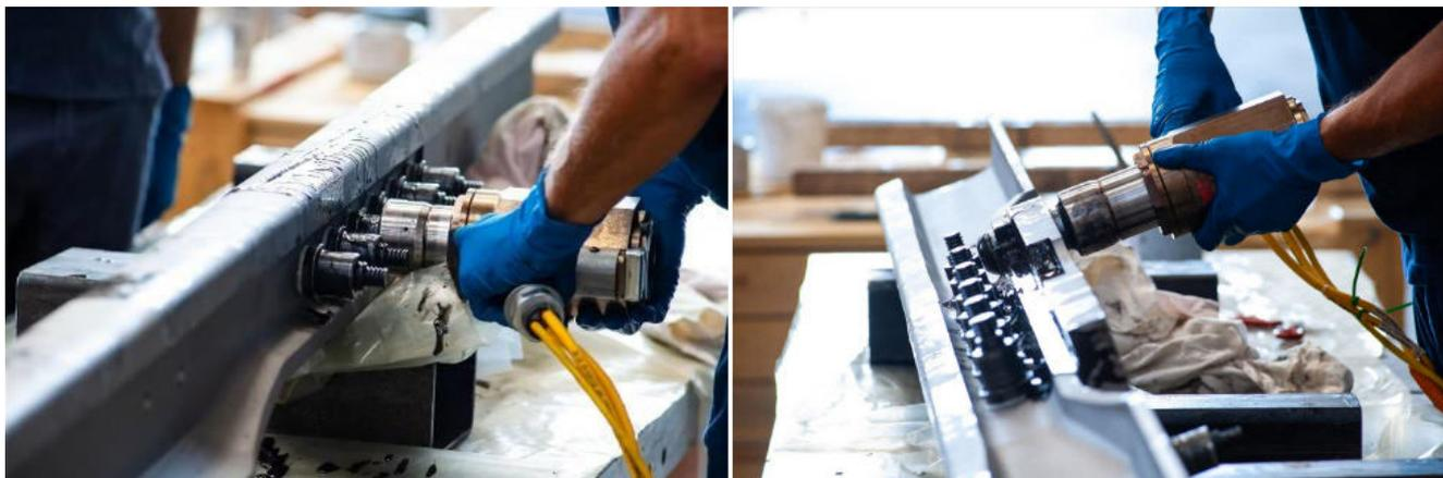
Figura 9 - Serraggio dei chiodi Huck con pistola idraulica.
