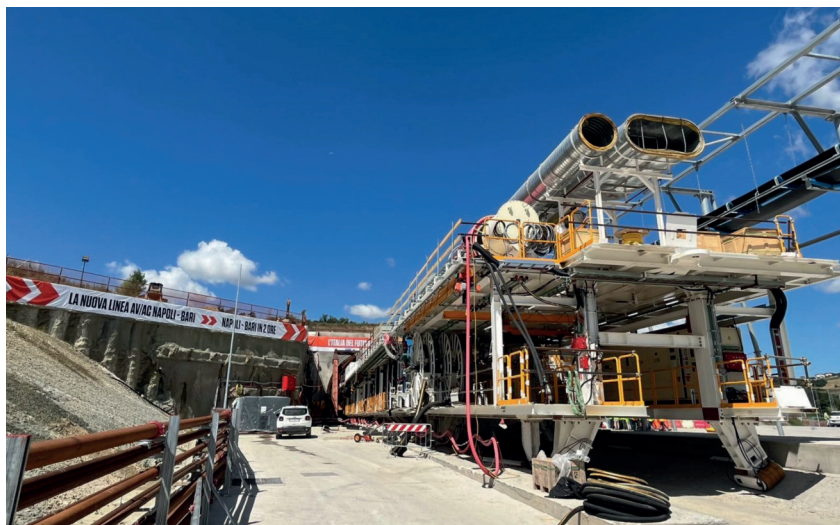
Figura 2 – Linea AV/AC Napoli-Bari: la fresa Aurora inizia lo scavo della galleria di Grottaminarda.
