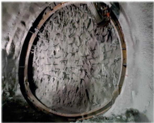
Figura 7 - Deformazione del fronte come conseguenza della natura tettonica dell'ammasso (faglia Sestri-Voltaggio).
