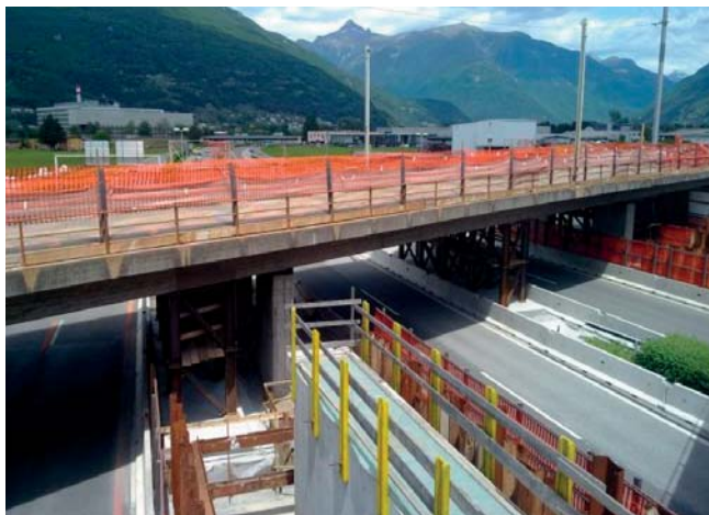
Fig. 14 - Puntellazione supplementare realizzata al di sotto del ponte A2 esistente per permetterne il taglio in conci. Fig. 14 - Supplementary shoring beneath the existing A2 bridge to allow segments to be cut.
