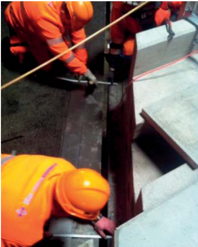
Fig. 37 - Si eseguono i controlli di misura in corrispondenza dei giunti trasversali tra spalle ed impalcato prima di iniziare le attività di foratura della piastra per la costruzione dei giunti definitivi.
