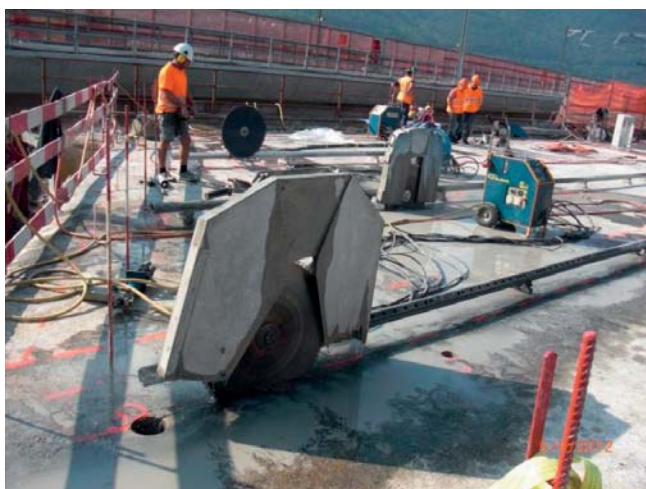
Fig. 16 - Operazioni di preparazione e di taglio della soletta, delle travi longitudinali e trasversali. Fig. 16 - Works to prepare and cut the deck and longitudinal and transverse beams.
