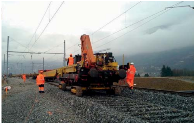
Fig. 27 - Rimozione delle campate di binario del tracciato esistente: tale operazione avviene in concomitanza allo sbarramento totale della linea ferroviaria Nr. 630.
