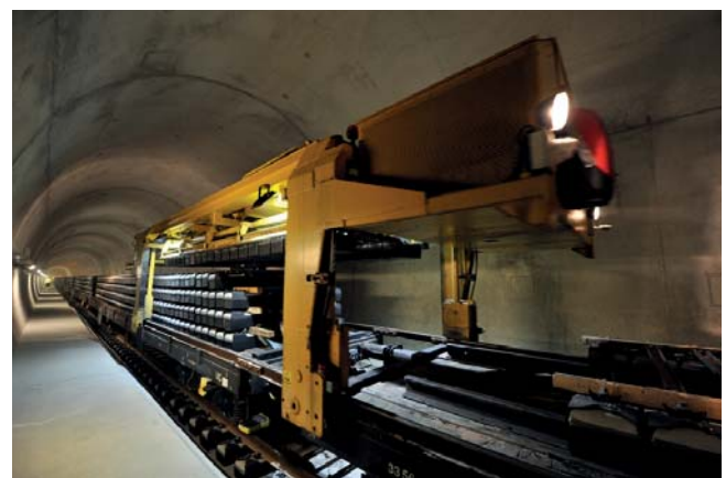
Fig. 3 - Treno per la costruzione della sovrastruttura ferroviaria rigida, particolare del satellite di trasporto delle traverse biblocco.
