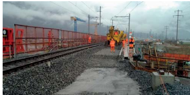
Fig. 28 - Rimozione della massicciata in corrispondenza dei giunti trasversali del cavalcavia e preparazione del piano di posa del futuro binario sul manufatto alla quota di progetto prevista.
