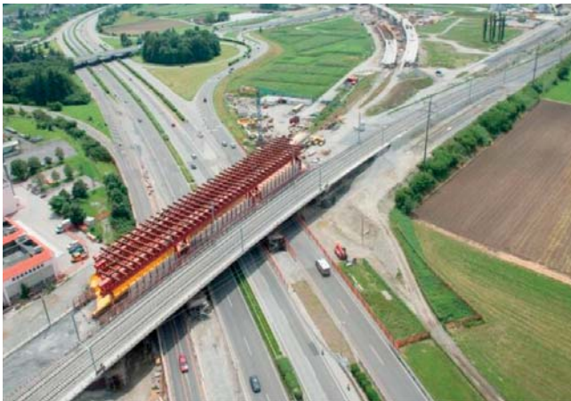
Fig. 47 - Vista aerea del nuovo cavalcavia A2 con la seconda metà, a servizio della nuova linea di base del Ceneri, in costruzione (agosto 2013).
