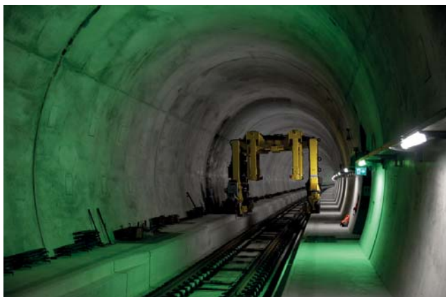
Fig. 4 - Carro gommato a cavaliere per il posizionamento delle rotaie.
