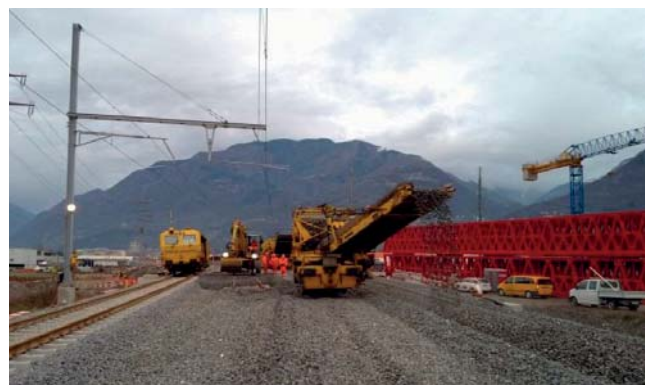
Fig. 30 - Contemporaneamente ai lavori di tecnica ferroviaria in corrispondenza del cavalcavia, si eseguono gli interventi di allaccio del nuovo tracciato a sud e a nord. Nella foto, da sinistra a destra, si osservano alcune attività in corso sul rilevato adiacente al cavalcavia: esecuzione del posizionamento plano-altimetrico del nuovo binario 300 LEM 630 con macchina rincalzatrice; stesa (a mezzo di escavatore a doppia via) del primo strato di massicciata sul tracciato del futuro binario 400 LEM630; movimentazione, a mezzo di treno di scavo, della massicciata non più necessaria e a servizio dei dismessi binari 300 e 400 LEM630 provvisoria.
