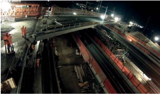
Fig. 32 - Alle ore 23.45 del 09.03.2013 le attività preliminari di tecnica ferroviaria e di opere civili sono concluse e può avere inizio, dopo le necessarie verifiche, la traslazione orizzontale dell'impalcato.
