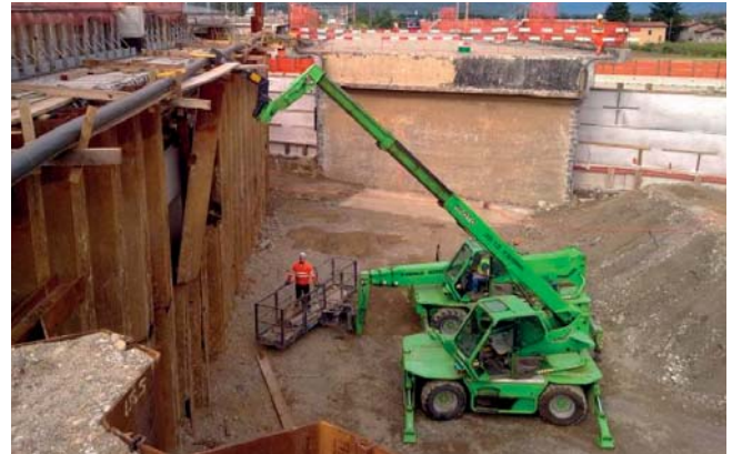
Fig. 19 - Rimozione delle palancole utilizzate per sostenere il sedime ferroviario durante la realizzazione della prima metà della spalla est del nuovo cavalcavia.
