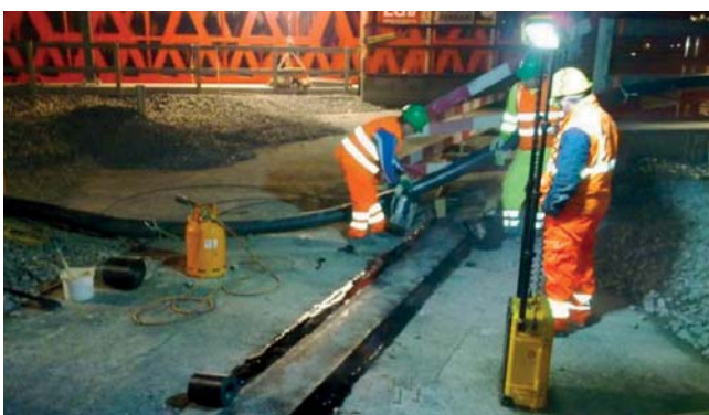
Fig. 39 - In netto anticipo rispetto alla programmazione definita, nella tarda serata del 10.03.2013 la prima metà di ciascun giunto trasversale è già completa e si attende la solidificazione del bitume posato in corrispondenza della seconda metà del giunto.
