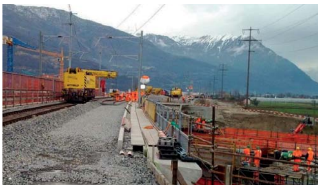
Fig. 29 - Operazione di posa delle campate del binario 300 - LEM630 sull'impalcato.
