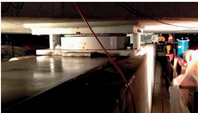
Fig. 34 - Particolare di uno degli appoggi dell'impalcato mentre scorre al di sopra della piastra lubrificata.
