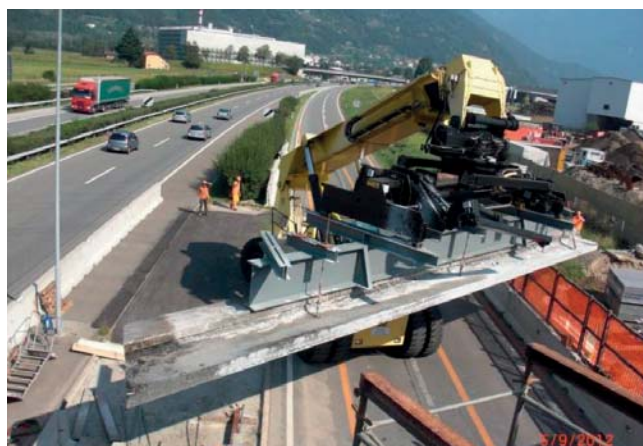
Fig. 17 - Rimozione dei singoli conci risultanti dal taglio del ponte esistente (a mezzo di gru Front Loader appositamente adattata). Fig. 17 - Removal of individual segments resulting from cutting the existing bridge (using an appropriately modified front-loader crane).
