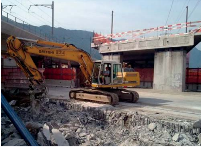
Fig. 18 - Demolizione delle fondazioni della spalla est del cavalcavia esistente con martellone.
