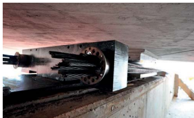
Fig. 26 - Appoggio del manufatto: dettaglio dell'attacco provvisorio del dispositivo di traslazione. L'appoggio è ancora privo degli elementi di fissaggio necessari ad impedirne la deformazione durante la traslazione.
