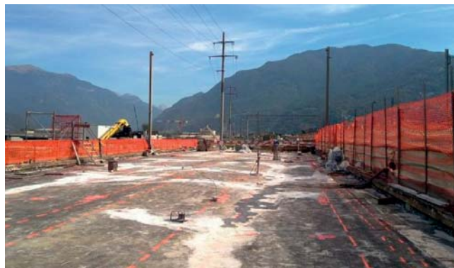
Fig. 15 - Tracciamento delle linee di taglio dei conci in corrispondenza della soletta del ponte vecchio esistente (si noti al centro, sullo sfondo, i tralicci della linea elettrica di alimentazione 70L - v. § 2.2). Fig. 15 - Layout of the cutting lines corresponding to the deck of the existing old bridge (the pylons of power line 70L are visible at the bottom - see § 2.2).
