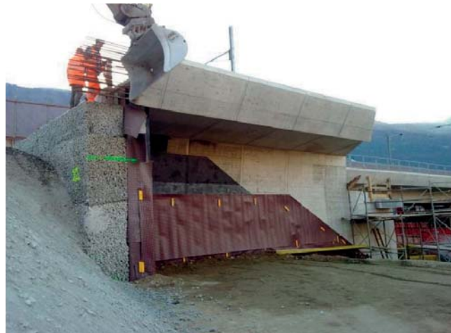
Fig. 21 - Ultime finiture della spalla est (cuneo stabilizzato, drenaggio ed impermeabilizzazione, già sagomati in previsione del profilo della successiva scarpata).
