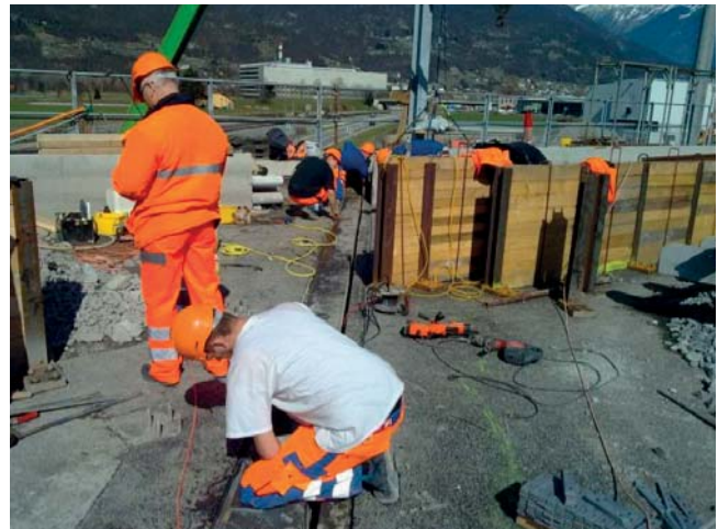
Fig. 38 - 10.03.2013: le squadre specializzate eseguono la prima metà di ciascuno dei due giunti trasversali, ovvero, quella al di sotto del futuro binario 400 LEM630 (tale binario dovrà essere in esercizio per le ore 05.00 del 11.03.2013). Terminata la prima metà di ogni giunto, sfruttando l'apposita ritenuta ghiaia già realizzata in corrispondenza di ogni spalla ed estremità dell'impalcato (ben visibile nella foto in alto e nella Fig. 22), senza soluzione di continuità prosegue la costruzione dei due giunti trasversali anche al di sotto del futuro binario.
