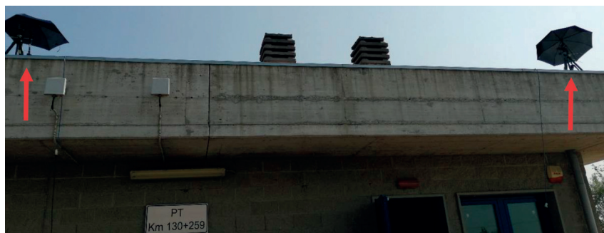
Figura 13 – Installazione delle telecamere sul tetto dell'edificio del PT Cadeo.
