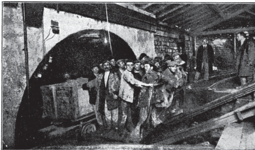
Fig. 22. - Il sottocarro all'imbocco del pozzo con carrello con una squadra di operai.
