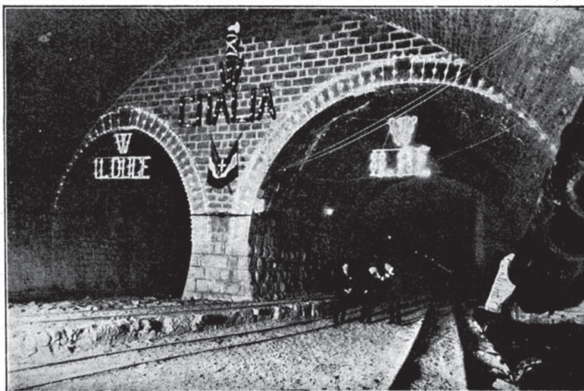
Fig. 27. — La testata della grande camera per la stazione delle precedenze: a destra la ferrovia a doppio binario; a sinistra la galleria ad un binario per le precedenze. Le fronti sono illuminate in occasione delle feste per l'incontro delle avanzate.
