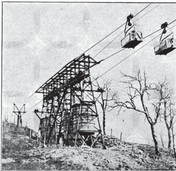
Fig. 3. — Un dispositivo di doppia tensione per le funi portanti della teleferica.
