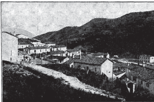
Fig. 5. - Il villaggio operaio all'imbocco Nord.
