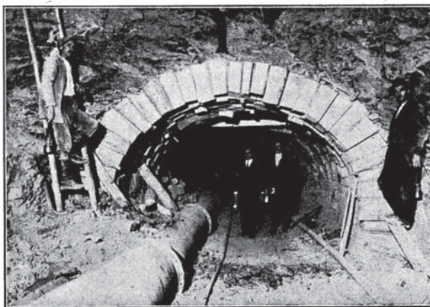
Fig. 26. — Il cunicolo inferiore all'imbocco Nord a sezione circolare rivestito con conchi di legname (botti).
