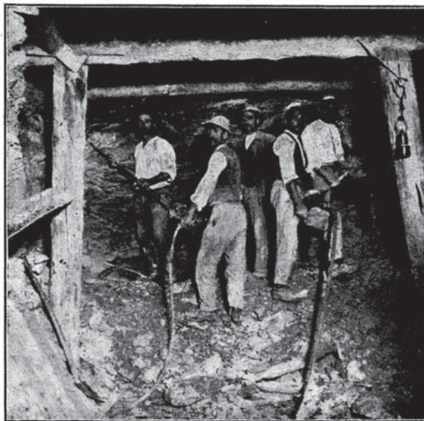
Fig. 25. - La fronte d'attacco del cunicolo superiore: due coppie di minatori con martelli perforatori.
