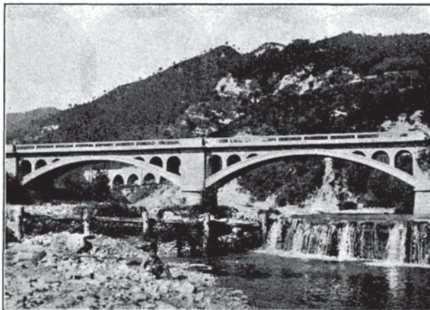
Fig. 2. — Ponte sul Setta a Gardelletta. Due archi in cemento armato, ognuno di m. 25 di luce.
