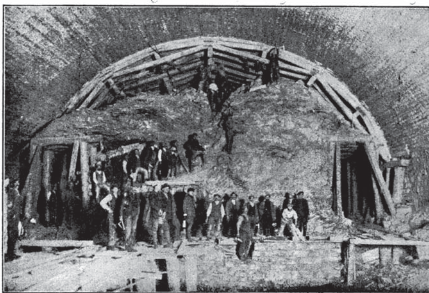
Fig. 28. — Lo scavo della grande camera per la stazione delle precedenza, per cunicoli in corrispondenza dei piedritti.
