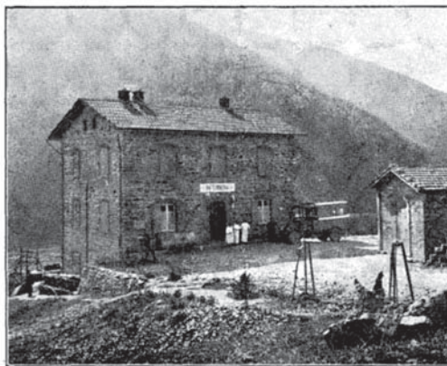
Fig. 8. — L'infermeria al cantiere dei pozzi.
