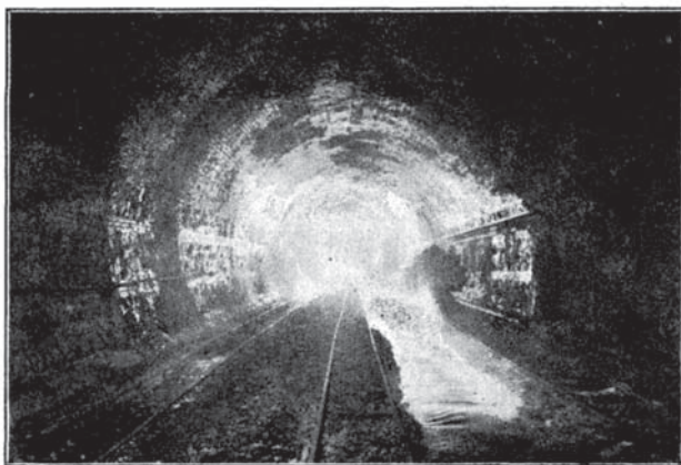
Fig. 31. - L'acqua di filtrazione proveniente dagli scavi scorre verso l'imbocco incanalato in apposita cunetta.
