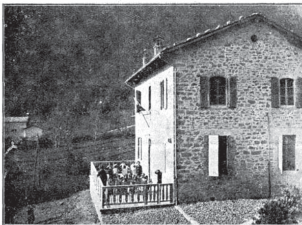
Fig. 7. — La scuola al cantiere dei pozzi.
