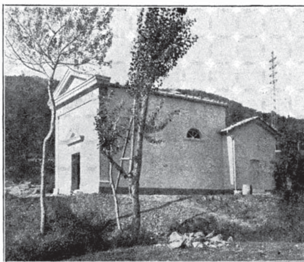
Fig. 6. - La chiesa al cantiere dei pozzi.
