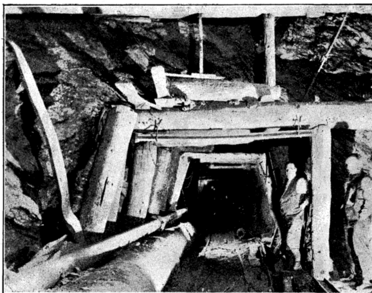
Fig. 24. - Imbocco del cunicolo inferiore del cantiere di strozzo.
