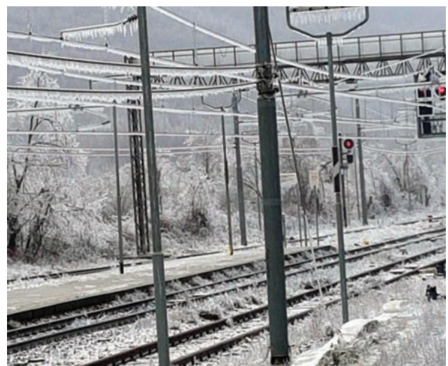
Fig. 7 – Il fenomeno del gelicidio sulle linee ferroviarie. Fig. 7 – The glazed frost phenomenon on railway lines.
