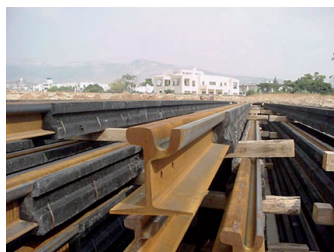
Fig. 10 – Rotaie rivestite nell'aeroporto di Hellinikon. Jacqueted rails at Hellinikon worksite.
