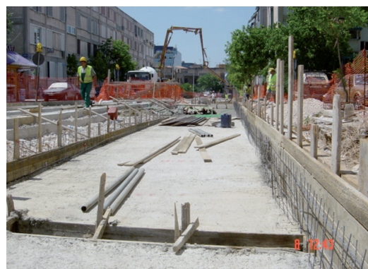
Fig. 14 – Preparazione del fondo e predisposizione zona seismic stopper. Preparing the bottom support and reservations for seismic stoppers.
