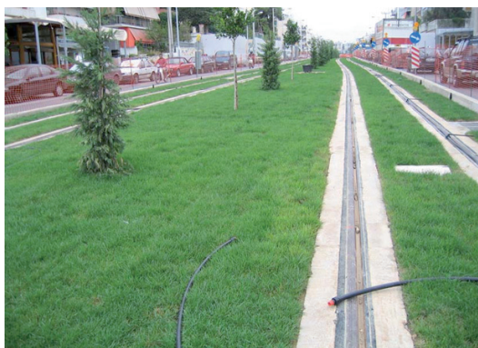
Fig. 12 – Installazione di rotaia ricoperta con manto erboso completata. Completed installation of Grass Track.
