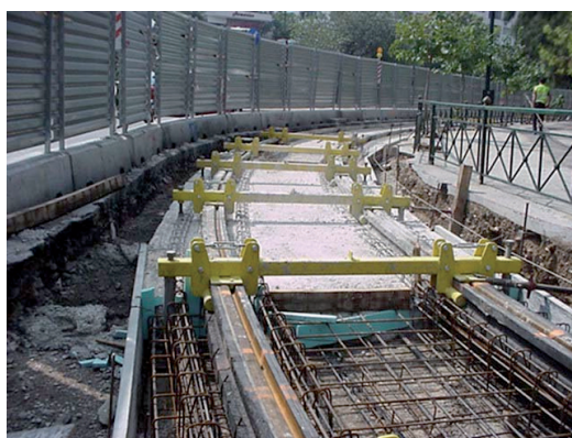
Fig. 11 – Installazione & copertura in cemento (sezione Zappion). Installation & concreting (Zappion section).
