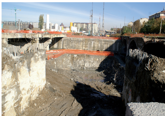
Fig. 46 - Scavo per costruzione soletto di sottopassaggio del fiume Dora.
