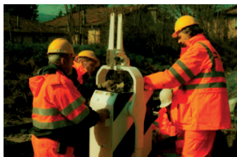
Fig. 4 – Installazione di una cassa per PL sulla rete RFI.
