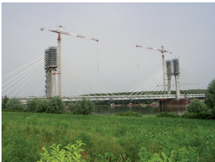
Fig. 4 - Ponte strallato sul Po (al momento della costruzione).
