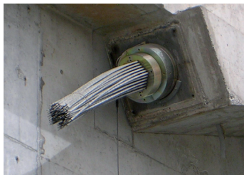
Fig. 5 - Attacco trefoli di uno strallo – foto Merlin.
