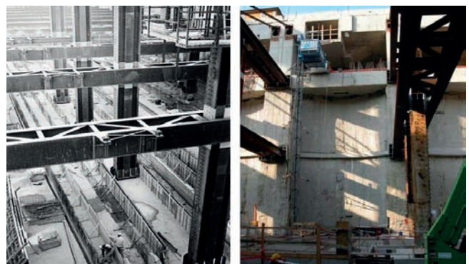
Fig. 20 - Le colonne e i telai trasversali. Fig. 20 - The columns and the transversal frame.
