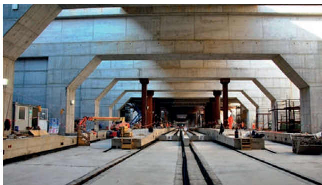
Fig. 19 - Parte bassa di un telaio speciale. Fig. 19 - Lower part of a special frame.
