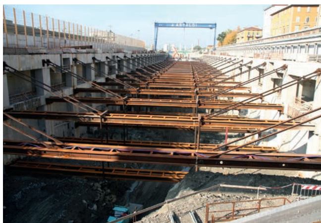
Fig. 17 - I diversi ordini di puntoni metallici in fase di scavo. Fig. 17 - Various orders of metal struts during excavation.
