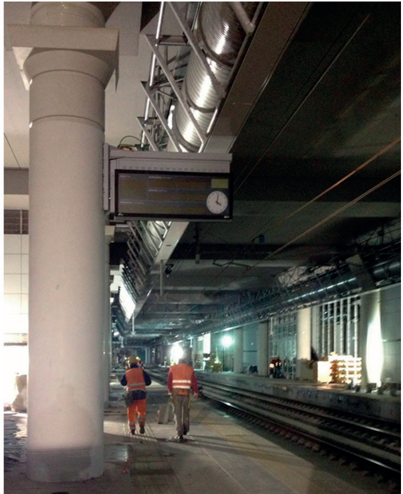
Fig. 18 - Le colonne e il rivestimento in GRC. Fig. 18 - The columns and the GRC coating.
