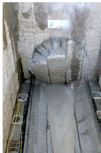
(Fonte Brescia Mobilità) Fig. 2 - La TBM abbatte il diaframma di fine galleria della metropolitana di Brescia.
