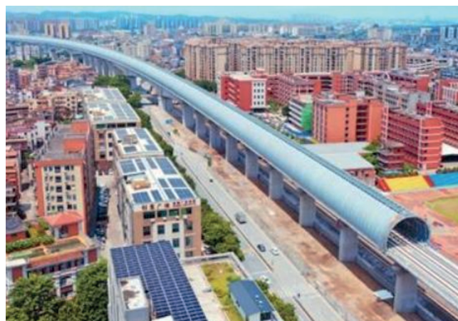
Figura 3 – Ricostruzione in simulazione della galleria insonorizzante per transito di treni Av in una città cinese. Figure 3 – Simulation reconstruction of the soundproof tunnel for high speed trains in a Chinese city.
