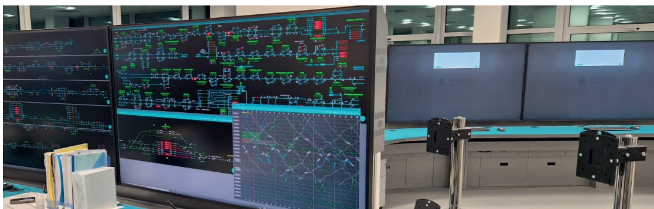
Figura 1 - Un altro passo avanti nell'ammodernamento complessivo dell'infrastruttura ferroviaria siciliana: conclusi i lavori di restyling della Sala Operativa Circolazione di Palermo, e attivato l'SCCM (Sistema Comando e Controllo Multistazione), moderno sistema di supervisione e regolazione della circolazione.
