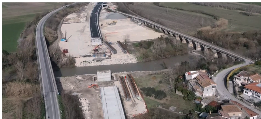
Figura 3 - Con il completamento dello scavo della Galleria Telese e la successiva realizzazione della campata unica di 65 m sul fiume Calore, tutti i principali ostacoli naturali presenti nella tratta Frasso Telesino - Telese saranno superati, consentendo così di dare un deciso impulso alle opere di sede e alla sovrastruttura ferroviaria, in vista del completamento in linea con gli obiettivi PNRR.
