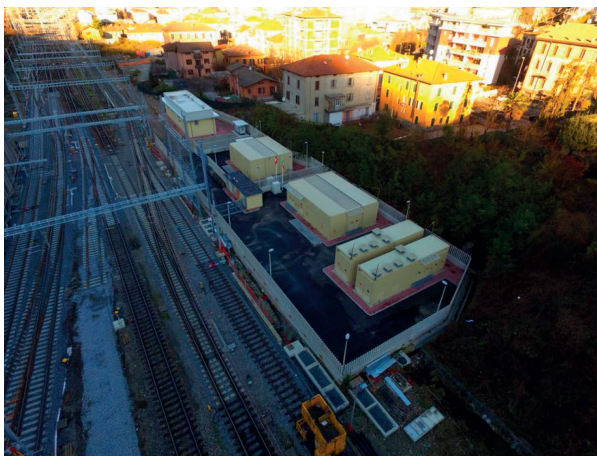
(Fonte: Regione Lombardia) Fig. 1 - Il nuovo impianto per l'alimentazione della TE.
