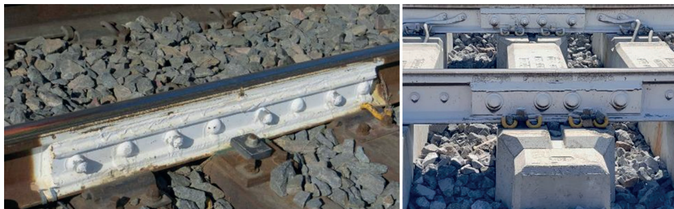
Figura 1 - GII con otto chiodi di bloccaggio (sinistra) [3]; GII supportato da una traversa speciale (destra). Figure 1 - GII with eight locking fishbolts (left)[3]; GII supported by a special sleeper (right).
