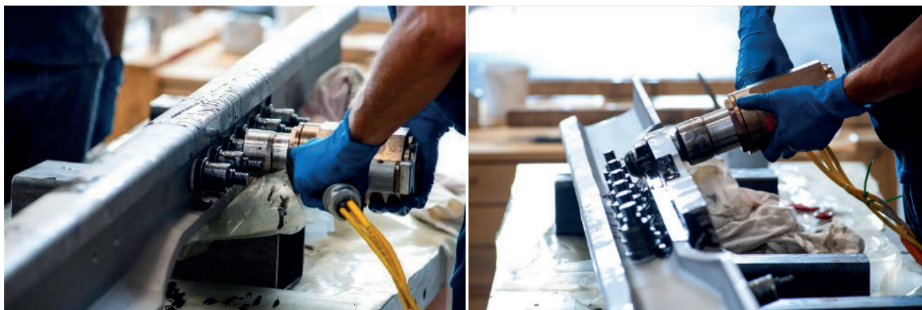
Figura 9 - Serraggio dei chiodi Huck con pistola idraulica. Figure 9 - Tightening Huck fishbolts with hydraulic tool.
