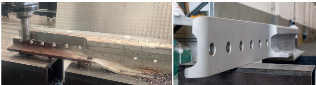
Figura 7 - Fresatura della barra per ago (sinistra), barra per ago lavorata e sabbata in fase di montaggio (destra). I due fori sull’anima della rotaia 60E1 servono per il collegamento dei cavi della corrente di ritorno verso le connessioni induttive. Tali cavi sono mostrati a scopo illustrativo in Fig. 6.
