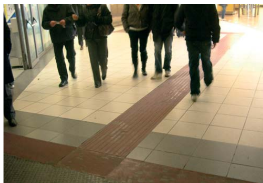
Fig. 4 - Roma, Stazione Termini. Percorso tattile nel collegamento tra stazione metropolitana e stazione ferroviaria.
