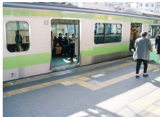
Fig. 1 - Giappone. Il percorso tattile segnala l'avvicinamento a una porta del treno.
