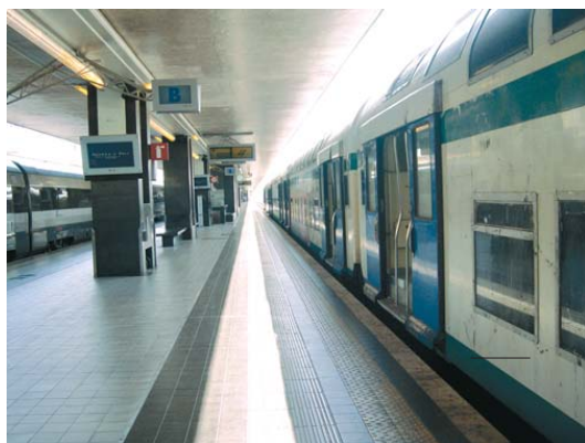
Fig. 2 - Stazione Roma Termini. Percorso tattile disposto lungo il binario, lungo circa 300 metri, non segnala un percorso significativo.
