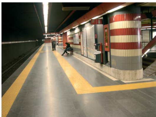
Fig. 6 - Roma, Metropolitana Linea A. Percorso tattile di avvicinamento a “banchina di imbarco”.
