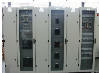
Quadro generale segnalamento Signalling main switch board
