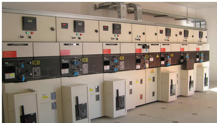
Fig. 5 - Quadro elettrico MT di cabina. MV board in cabin.
