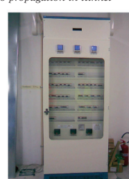
Quadro distribuzione segnalamento Signalling Distribution Board
