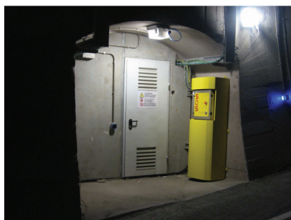
Help Point e Illuminazione d'emergenza Help Point and emergency lighting
