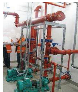
Impianto idrico antincendio Fire water plant
