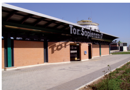
Fig. 8 - Fermata di Tor Sapienza in galleria artificiale: atrio di ingresso con rivestimento in mattoni romani e pavimentazione esterna in massello autobloccante in calcestruzzo. Sullo sfondo il camino di ventilazione della galleria.
