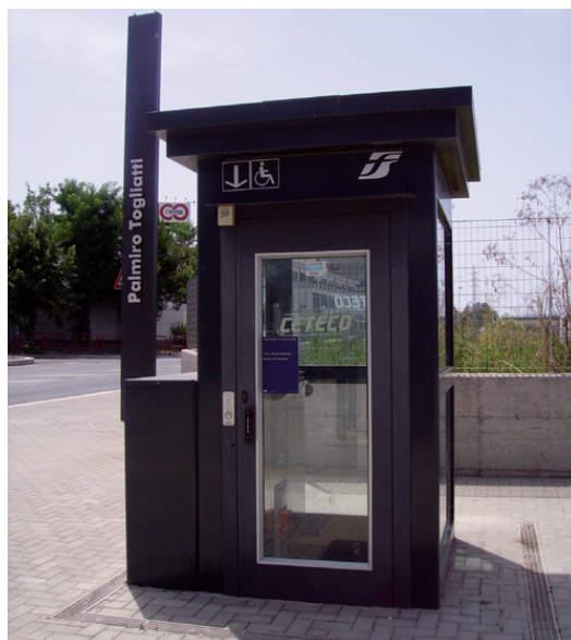
Fig. 7 - Fermata di Palmiro Togliatti: particolare dell'ingresso con il "totem" per la segnaletica di fermata e la piattaforma elevatrice per il superamento delle barriere architettoniche.
