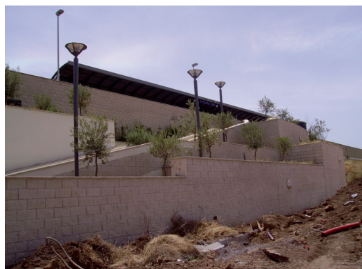
Fig. 12 - Fermata di La Rustica Città in galleria artificiale: particolare della scala a gradoni rivestita in blocchetti in cls slittati (finto travertino) con gli alloggiamenti per le piantumazioni (alberi di ulivo).
