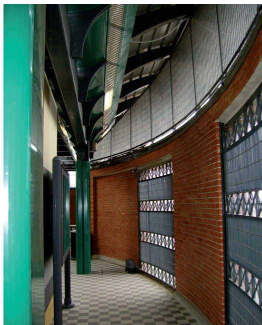
Fig. 9 - Fermata di Tor Sapienza in galleria artificiale: atrio di ingresso e particolari della pavimentazione in gres porcellanato posata a scacchiera e dei cancelli di chiusura elettrici e remotizzati.
