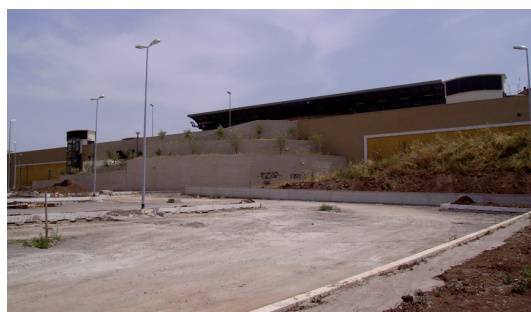
Fig. 11 - Fermata di La Rustica Città in galleria artificiale: scalinata di ingresso alla fermata e prospetto della galleria artificiale.
