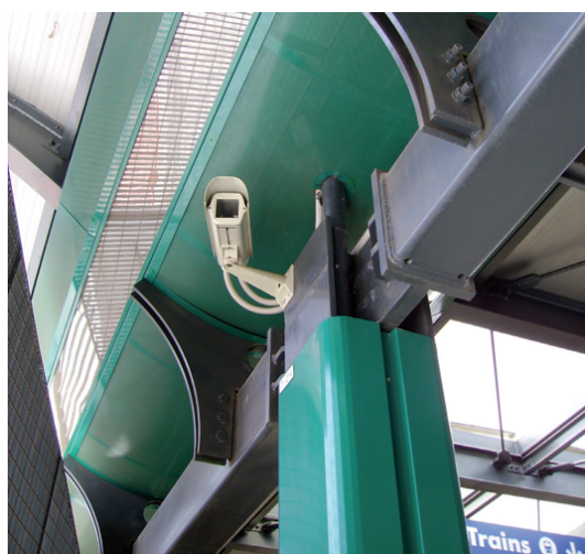
Fig. 17 - Pensilina di fermata: particolare della carpenteria metallica (pilastro, trave, illuminazione e pluviale) e del sistema di video sorveglianza.
