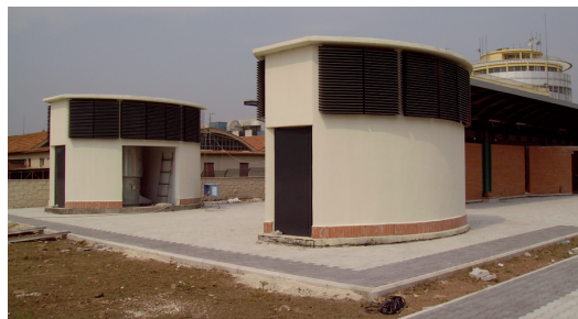
Fig. 19 - Camini di ventilazione situati sull'estradosso della galleria artificiale.
