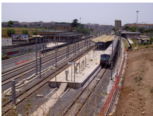
Fig. 3 - Stazione di Prenezzina: banchina ad isola con pensilina ad ala di gabbiano.
