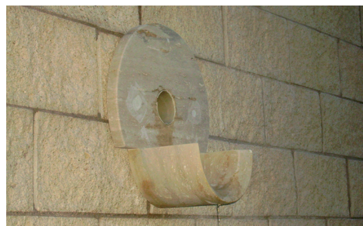
Fig. 21 - Realizzazione del particolare architettonico della bocca di lupo per la parete a gradoni della fermata di La Rustica Città. (Cfr.: bozzetto in fig. 25).
