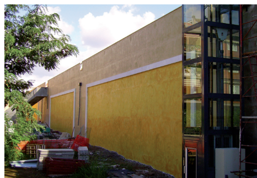
Fig. 20 - Galleria artificiale: particolare delle finiture riquadratura in travertino naturale con pitturazione, interna alla cornice, in giallo ocra e l'esterno in colore tortora. In primo piano la piattaforma elevatrice per il superamento delle barriere architettoniche.
