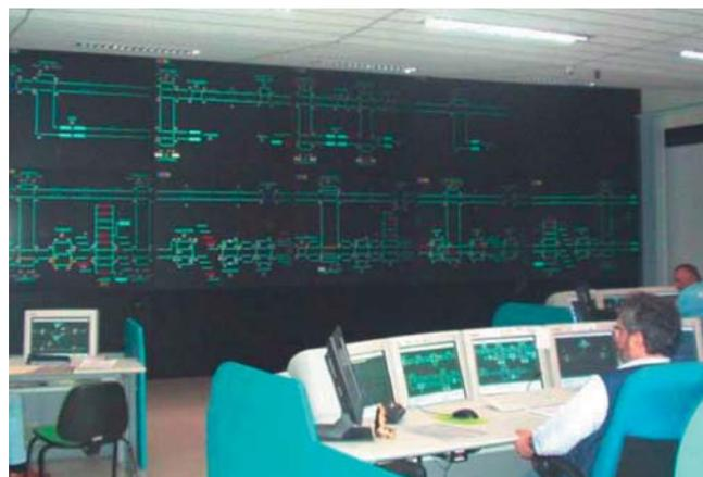
Fig. 81 – Quadro sinottico a retroproiezione.
