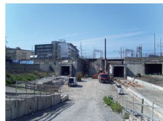
Fig. 21 - I due monoliti in opera al termine della prima fase.
