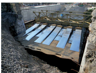
Fig. 16 - Inizio del varo con i lamierini antistrascinamento in evidenza; in 2° piano il monolite 2 in attesa.
