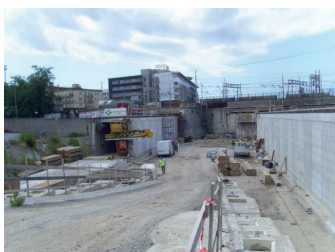
Fig. 17 - Il monolite 1 durante il varo, a destra il monolite 2 in attesa.
