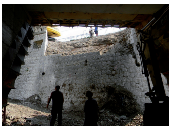
Fig. 15 - Demolizione della parete per l'ingresso nel terrapieno.
