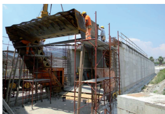
Fig. 12 - Montaggio dello scudo successivo alla costruzione del manufatto.
