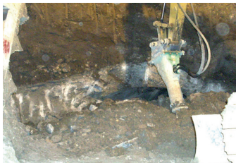
Fig. 18 - Demolizione della massiccia: calotta in calcestruzzo del cunicolo.
