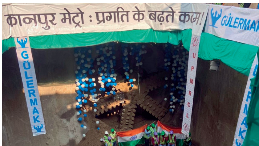
Figura 3 – La conclusione dello scavo della galleria con l'abbattimento del diaframma della metropolitana di Kanpur.
