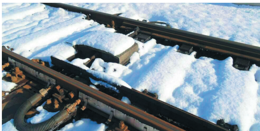
Figura 3 – Circa 7400 scaldiglie per deviatori mantengono i punti di variazione dell'itinerario liberi dalla neve.
