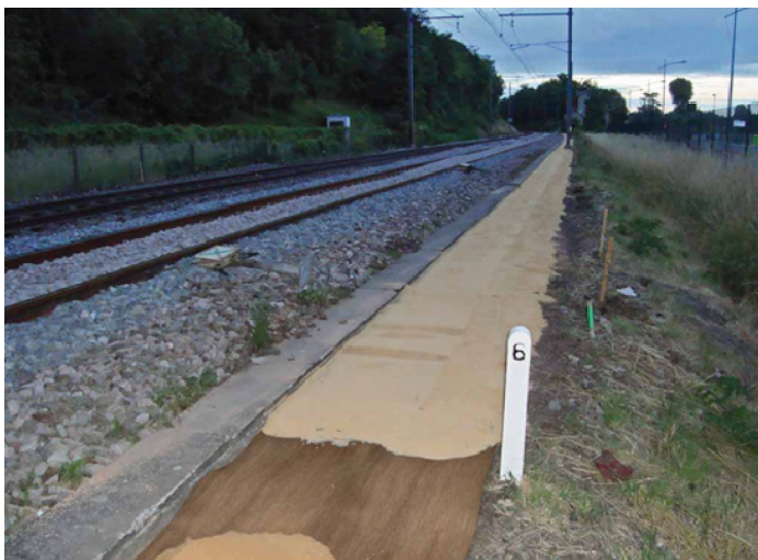
Fig. 5 - Francia, linea ferroviaria che collega Moret/Veneux-les-Sablons e Lione: per controllare l'invasione delle erbe infestanti in un'area sensibile a livello ambientale (area protetta di approvvigionamento d'acqua) senza l'utilizzo di erbicidi, è stato installato il geotessile in un'area dove le macchine e i pedoni possono attraversare i binari grazie a un segnale e una barriera di controllo.
