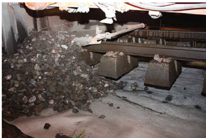
Fig. 6 - Francia, linea ferroviaria che collega Moret/Veneux-les-Sablons e Lione: posa della massicciata sul geotessile.
