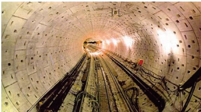
Fig. 5 - Gallerie: rivestimento previsto con lo scavo meccanizzato.
