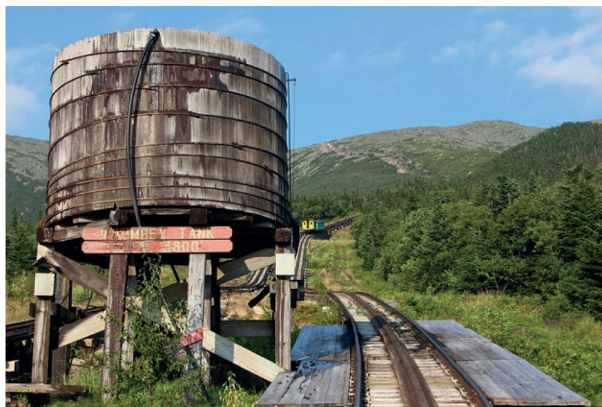
Fig. 6 - Tratto di raddoppio con serbatoio dell'acqua: Foto Roy Luck-Lic.CC2.0 / Un tratto intermedio di raddoppio del binario per l'incrocio dei treni, con serbatoio per la ricarica dell'acqua / 2018. (Archivio R. CAMBURSANO). Fig. 6 - Doubling tract with water tank: Photo Roy Luck-Lic.CC2.0 / An intermediate doubling of the track for the crossing of the trains, with a tank for refilling the water / 2018. (Courtesy R. CAMBURSANO).
