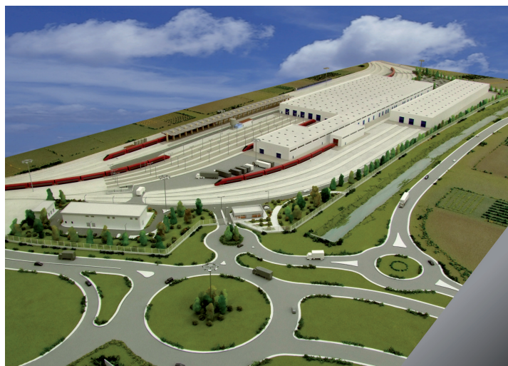
Fig. 1 – Il costruendo polo manutentivo per la flotta di NTV.
